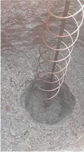
Un sistema de P.A.T. puede basarse en un pozo o en varios unidos, en este caso hablamos de una malla. En la costa, en la mayoría de puestos a tierra, se construye fácilmente pozos verticales de dos a tres metros de profundidad.
